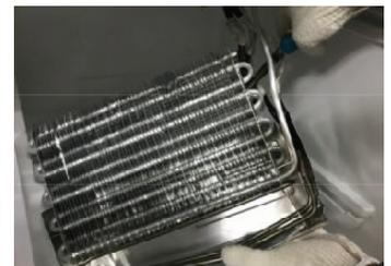
9. Levante los clips que sostienen el calentador de descongelación y luego retire el calentador.
